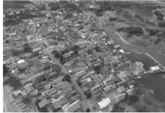
Gambar 2. Permukiman di Bantaran Sungai Sumber: Peneliti, 2021
